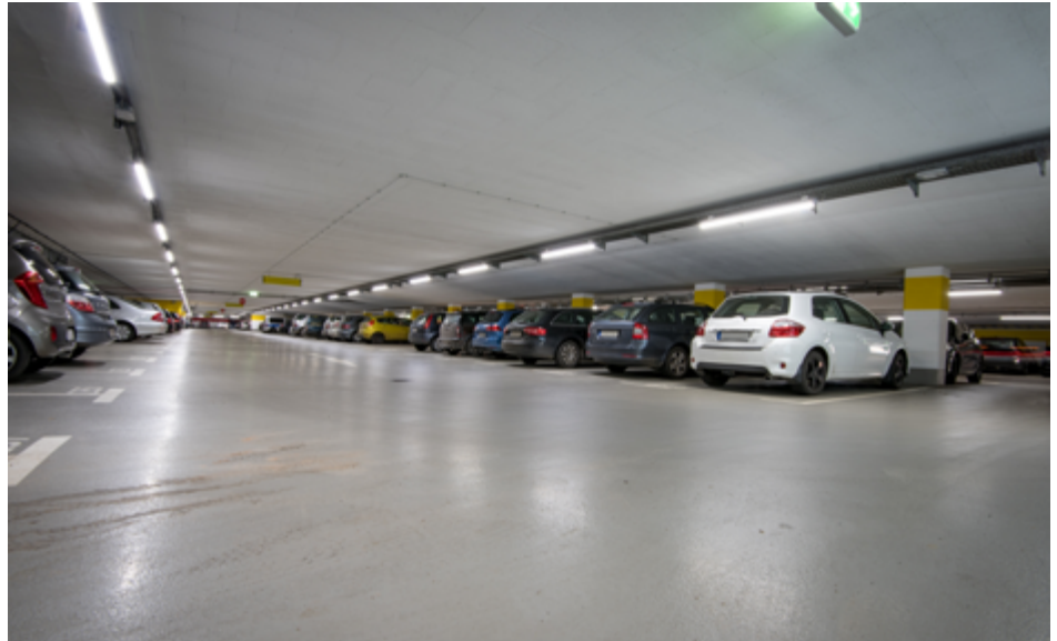
Abb. 13: Tiefgarage mit CO-Sensor
